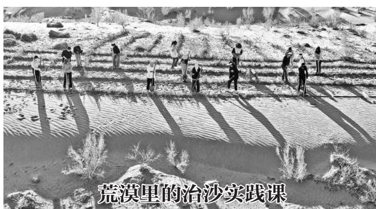
近日,甘肃省张掖市临泽县北部荒漠防沙治沙区,河西学院的大学生们在工作人员的指导下进行用麦草压沙障,并在压好的沙障中栽种梭梭苗。学生们在实践课堂中更加深刻地了解一代又一代人的防沙治沙过程,认识到保障西北绿洲生态安全的重要意义。王将 摄
