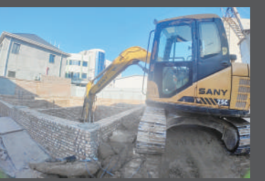
房山区窦店镇苏村修缮房屋
