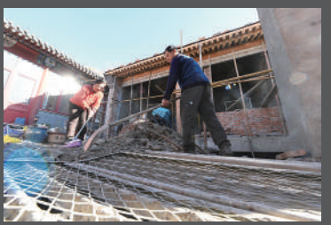
门头沟区韭园村村民苏朋与妻子武洪亮正在修缮被洪水冲坏的房子
