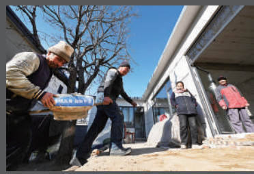
房山区窦店镇苏村村民穆瑞林翻建被洪水损坏的房屋
