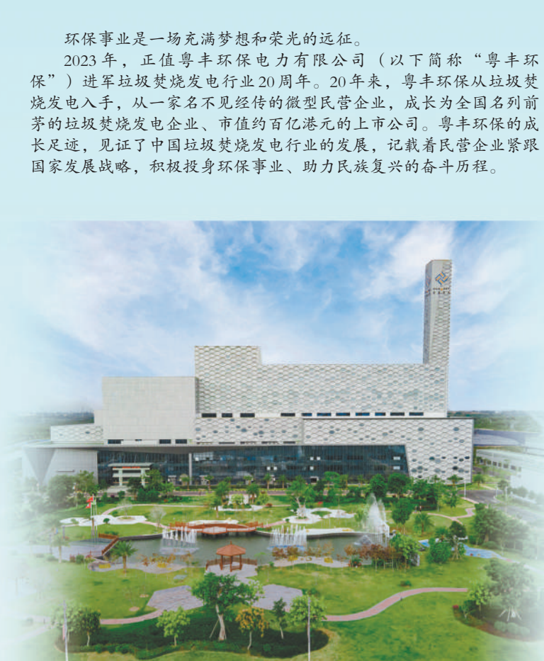
获得鲁班奖的茂名电白垃圾焚烧发电项目
